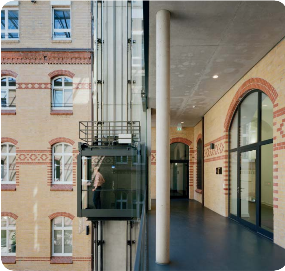
Bauteil 2, Flucht- und Rettungsweg in Hof II: Türanlagen für den Brandschutz und Rauchschutz sind historisierend ausgebildet. Foto: Fotografie Dorf Müller Klier.
