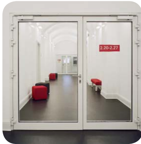
EI(T) 90-Türsystem mit Pilkington Pyrostop® zur Sicherung eines Brandabschnitts. Foto: Fotografie Dorf Müller Klier.
