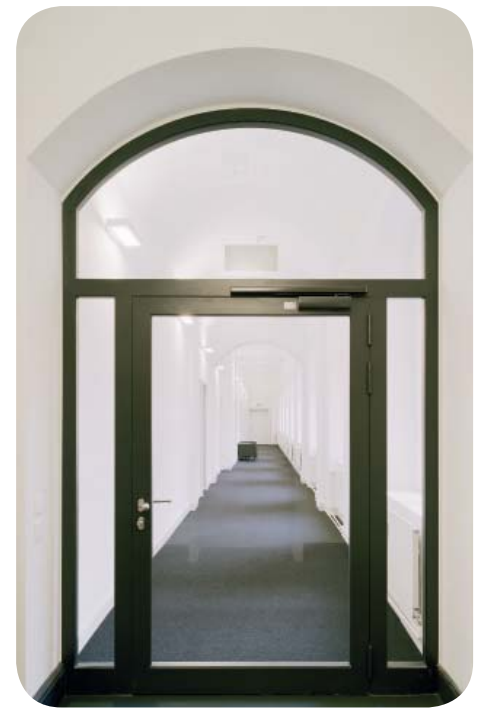
Brandschutz meets Rauchschutz: Im historischen Bauteil 2 wurden lange Flure zur Bildung von Brand- und Rauchabschnitten mit EI(T) 30-Türen und Rauchschutz-Türanlagen neu unterteilt. Fotos: Fotografie Dorf Müller Klier.
